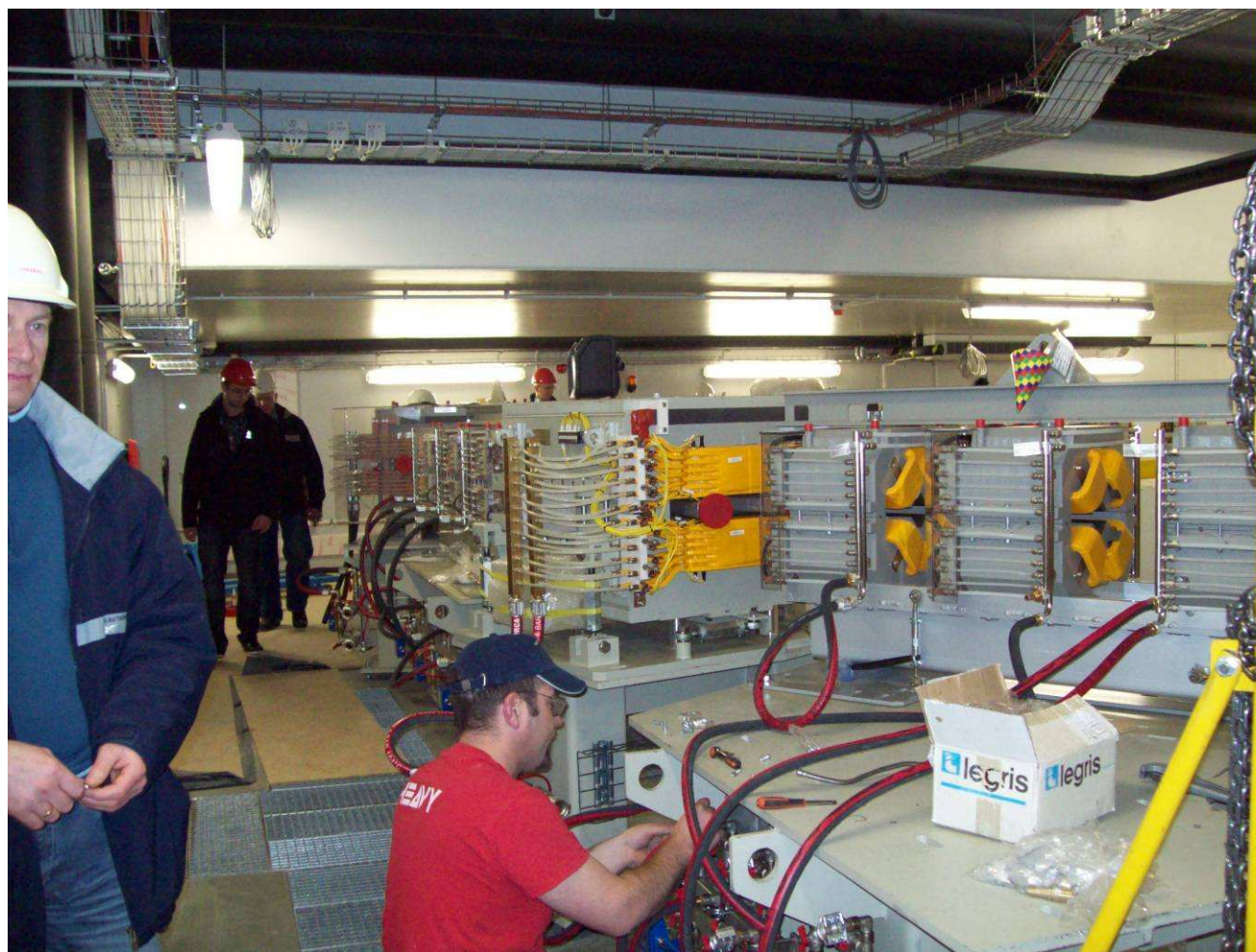
Instalacja magnesów linii prowadzenia wiązki 11.04.2012
